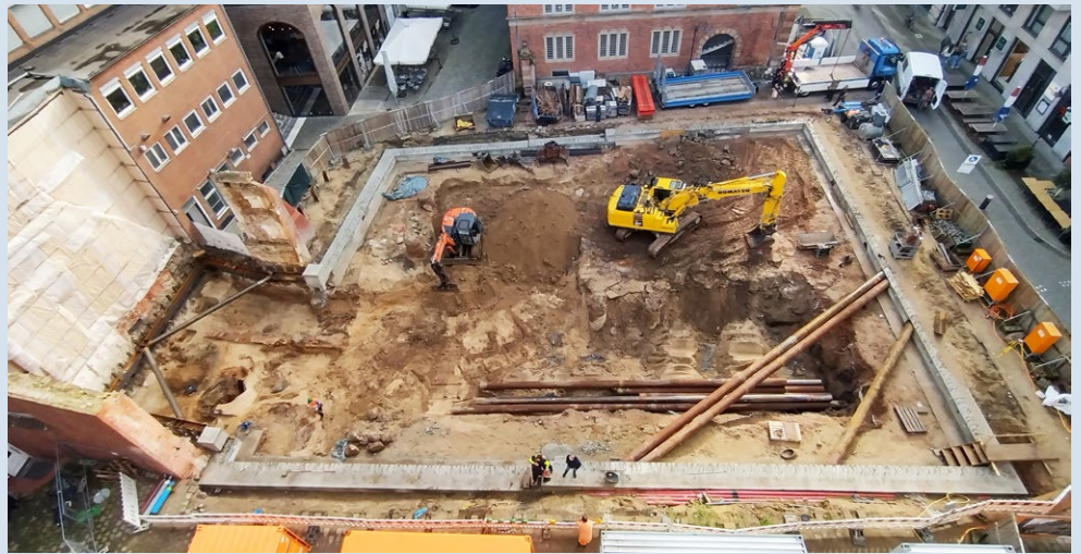
Herstellung der Baugrube für den Neubau des historischen Essighauses in Bremen.
