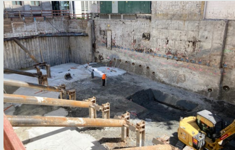
Niedenu 84 nach Aushub der fertigen Baugrube.
