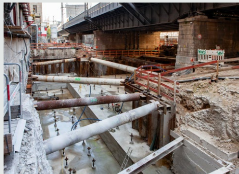
Fertige Baugrube für die Archäologische Promenade.
