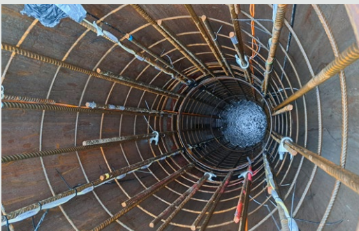
Thermische Integritätsprüfung mit Thermal Wire® von PDI.
