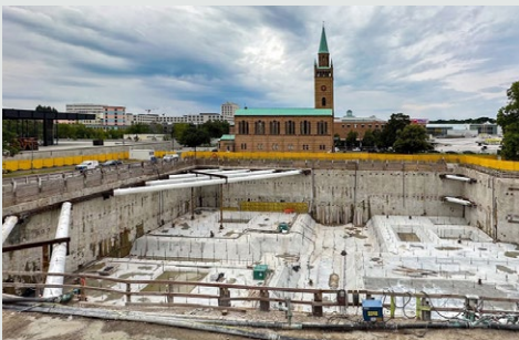
Die fertiggestellte Baugrube am Berliner Kulturforum.
