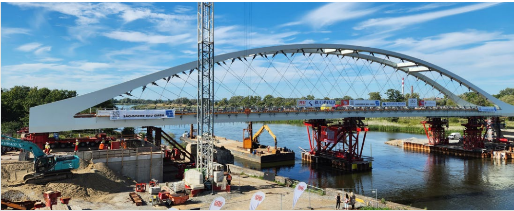
Der Brückeneinschub der Eisenbahnüberführung Küstrin wurde am 5. September 2023 abgeschlossen.
