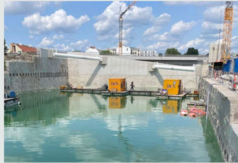
Letztes Querschott vor dem Rückbau.
