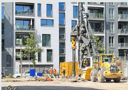
Bohrpfahlarbeiten in der Tieckstraße 18 in Berlin-Mitte.
