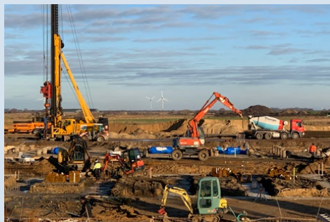
Gründungs- und Erschließungsmaßnahmen auf Föhr.
