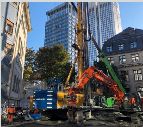
Herstellung der Bohrpfähle in Frankfurt Westend.
