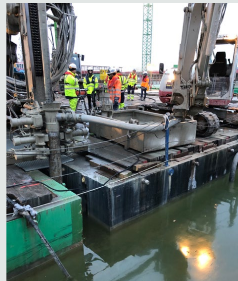
DSV-Geräte auf einem Ponton mit gezielter Fassung der Rücklauf-suspension.
