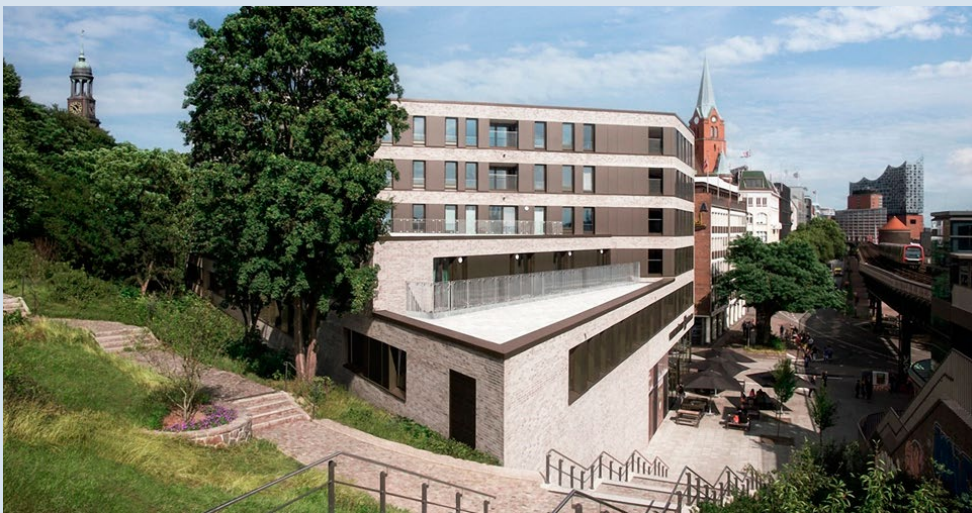
Der Neubau am Hafentor 7 in Hamburg wurde direkt über einem S-Bahn-Tunnel errichtet.
