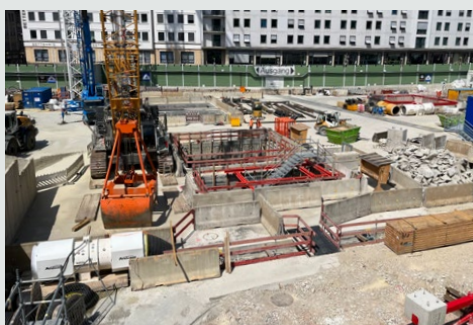
Die ausgehobene Baugrube der Station Marienplatz.
