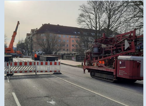
Vorbereitung für Wasserbohrungen im Goldbekkanal.
