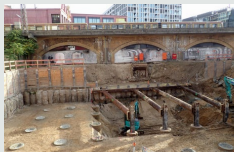
Anspruchsvolle Planung direkt am Stadtbahn-Viadukt.
