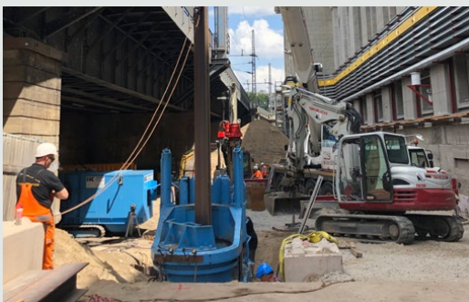
Gründungsarbeiten inmitten historischer Bausubstanz.
