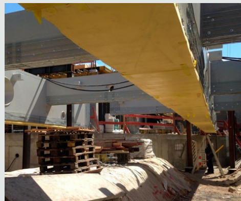
Abfangkonstruktion des Neubaus über dem U-Bahn-Tunnel während der Bauphase.
