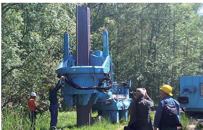
Herstellung der Abstomsicherung (Spundwand) in Rostock.
