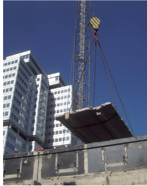
Krangeführter Rückbau beim Bauvorhaben DRV-Rechenzentrum.
