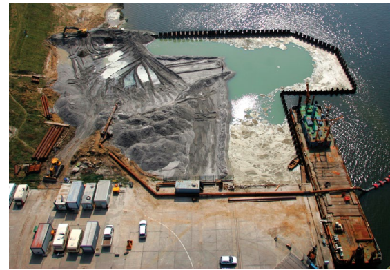
Erweiterung Liegeplatz 60, Rostock
