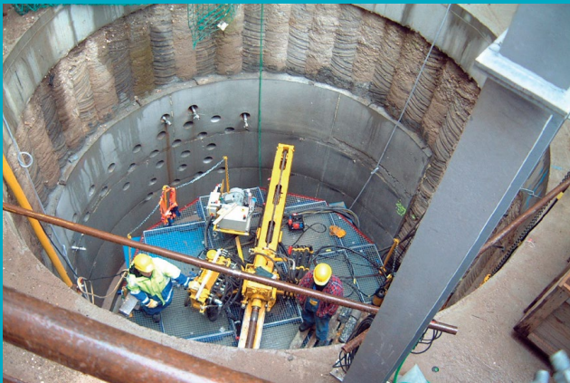
City-Tunnel Leipzig: Schachtbaugrube für die Gebäudesicherung mittels Compensation-Grouting-Verfahren (CGV)
