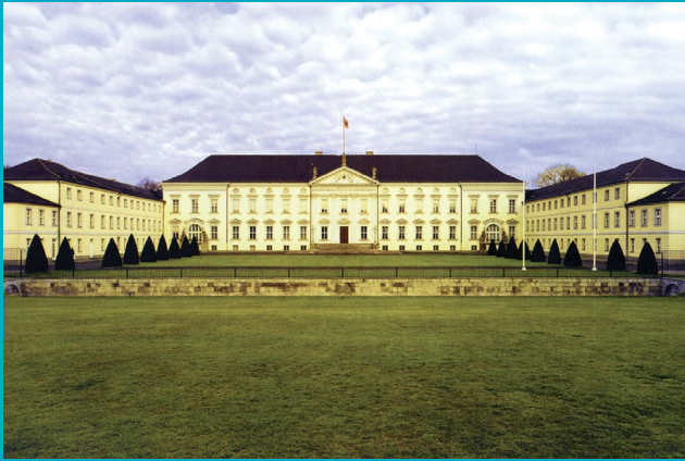
Nachträgliche Herstellung eines Kellergeschosses im Schloss Bellevue im Düsenstrahlverfahren
