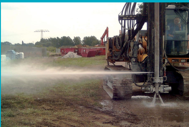
Düsenstrahlarbeiten beim Ökologischen Großprojekt der Leuna-Werke
