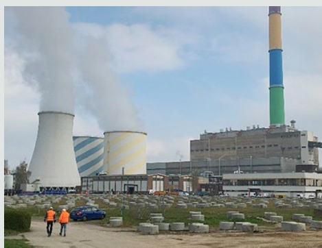
Kontinuierliche Erschütterungsüberwachung bei Baumaßnahmen am Kraftwerk Chemnitz
