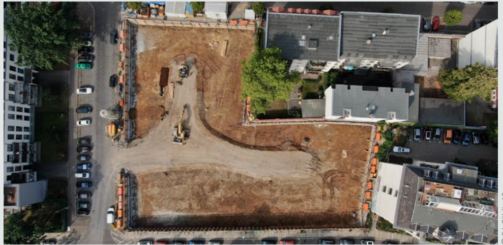
Anspruchsvolle Baugrube für das Wohnbauprojekt LAVIDA in Leipzig
