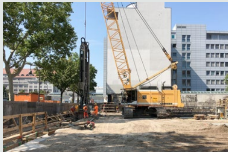
Baugrube des neuen DGB-Hauses im Bau
