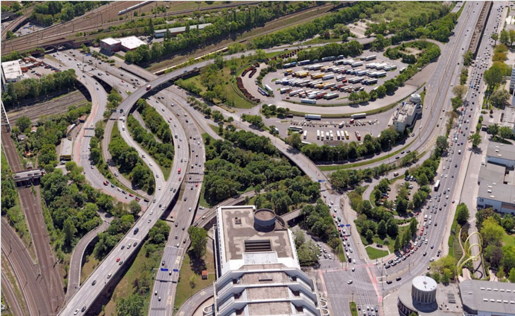
Ingenieure der GuD begutachten im Auftrag der DEGES den Baugrund für das Autobahndreieck Funkturm
