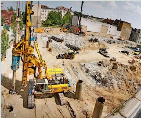
Die umfangreichen Gründungsarbeiten im Tegel-Quartier wurden im Sommer abgeschlossen.
