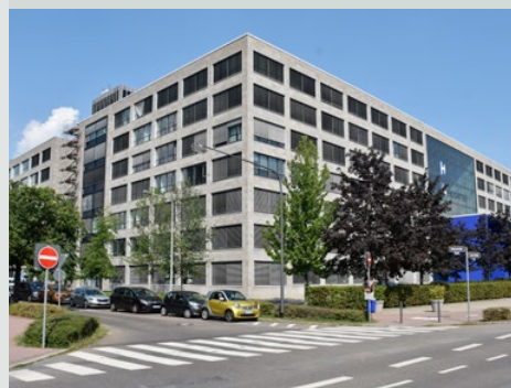
Der neue GuD-Standort in Frankfurt Niederrad
