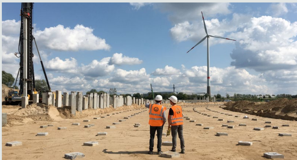
Einbau der Ramm-pfähle für die beiden neuen Verbindungsrampen
