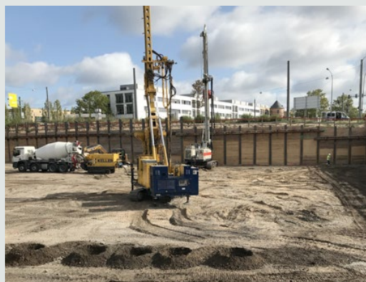
Baugrundverbesserung im Havelquartier Potsdam.
