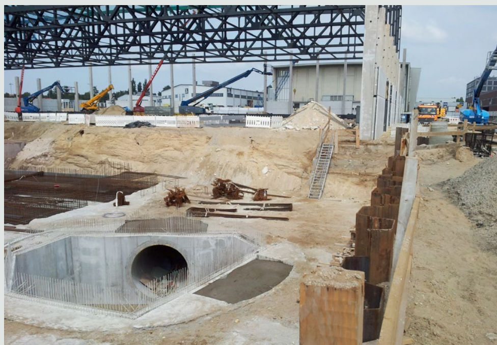
Vorne: Medientunnel im Bereich des Kopfbaus, hinten: Außenstützen und Stahlfachwerk der Hallenkonstruktion
