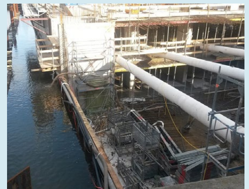
Baugrube am Hamburger Brooktorhafen für den Erweiterungsbau der Unternehmenszentrale Gebr. Heinemann.
