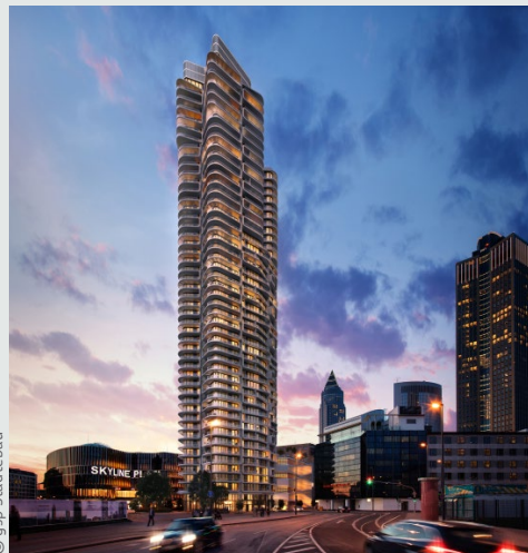
Der Grand Tower in Frankfurt am Main wird mit 172 m das höchste Wohngebäude Deutschlands sein.
