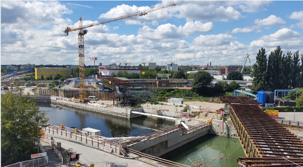
Baustelle des 16. Bauabschnitts der BAB A100 im Sommer 2016 am Autobahndreieck Neukölln.
