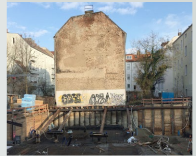
Sensible Nachbarbebauung Damerowstr.
