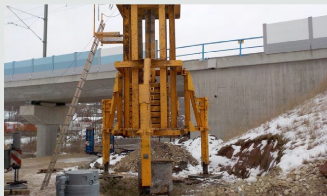
Dynamische Pfahlprobebelastung (dahinter Brückenbauwerk).
