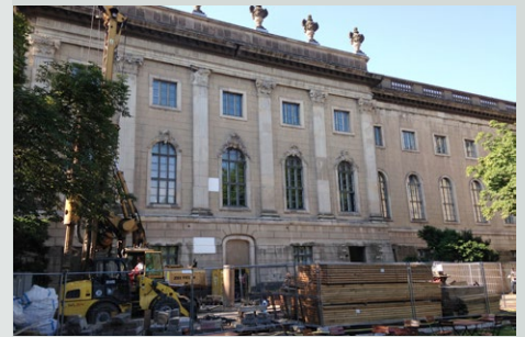
Sanierung bei beengten Platzverhältnissen.
