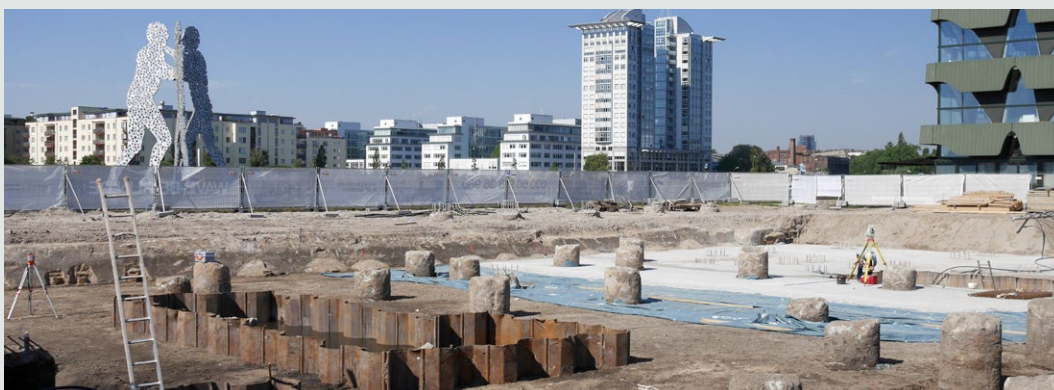
Herstellung der Bodenplatte und der Bohrpfähle vor der Kulisse der berühmten Molecule Men in der Spree.
