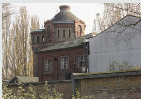
Historischer Bestand, teilweise mit Asbest verkleidet.
