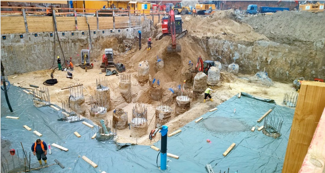
Ausführung einer KPP-Gründung zur Optimierung des Setzungsverhaltens.
