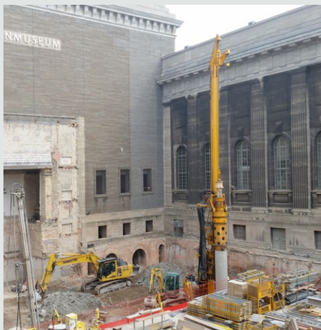
Spezialtiefbauarbeiten im Tempietto.
