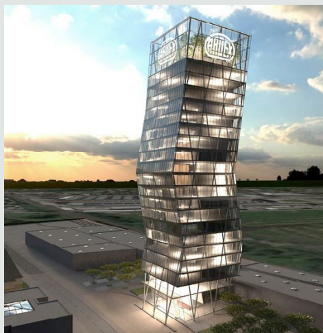
Der ARDEX-Tower wird architektonischer Mittelpunkt des ARDEX-Campus in Witten.
