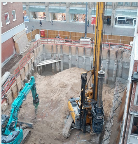
Die Baugrube für das neue Stammhaus der Johann Jacobs GmbH soll im Februar 2019 fertig sein.
