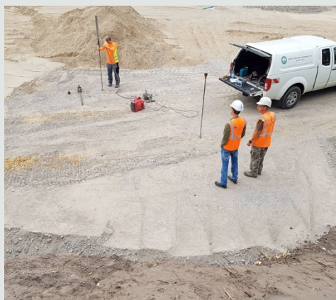
Sohlabnahme am BW 80 Ü1 im August 2018.
