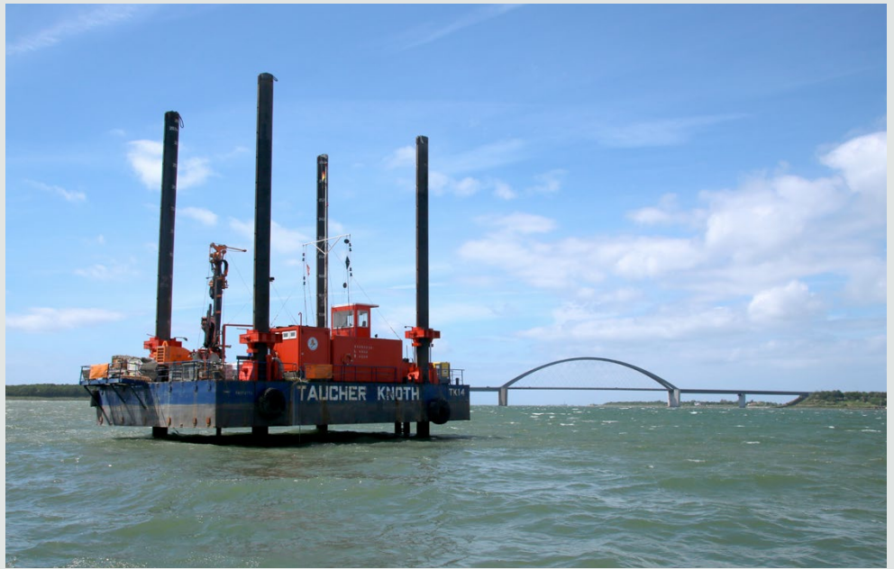
Nearshore-Baugrunderkundung für die neue Fehmarnsundquerung.
