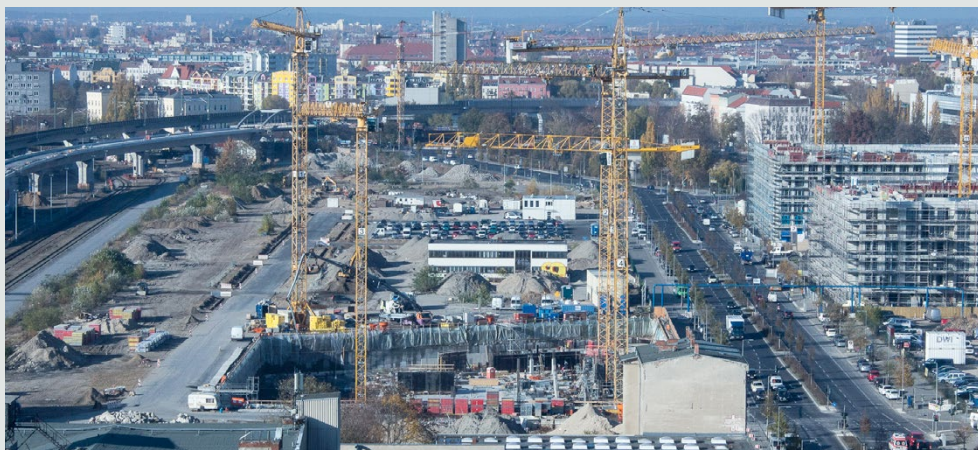
Blick vom TOTAL-Tower über das Quartier Heidestraße mit Baugrube für das Teilprojekt „Core“.
