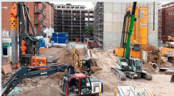
Die Baustelle in der Ritterstraße Nähe Moritzplatz.
