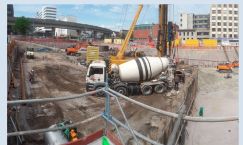
Gemeinsame Baugrube für 3 Neubauten.
