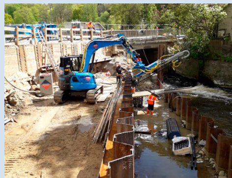
Bauarbeiten an der historischen Ufermauer.
