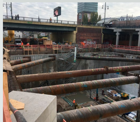
Die Hochhaus-Baustelle an der Warschauer Brücke.
