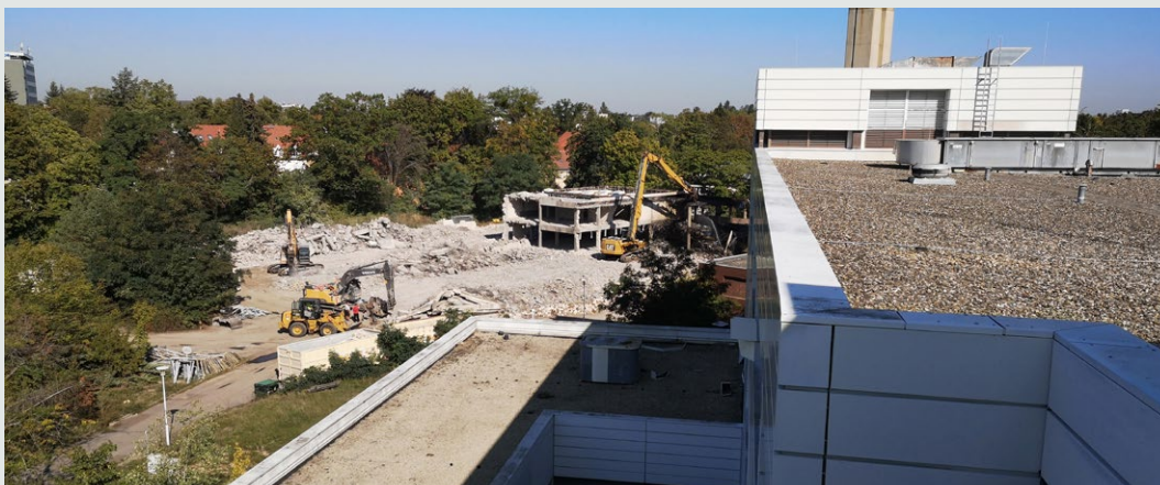
Der Rückbau der Gebäude hat begonnen.
