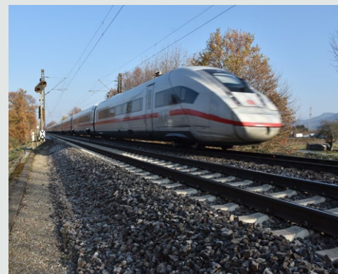
Die Bahntrasse soll für 200 km/h ertüchtigt werden.
