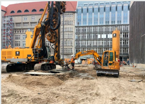
Grundbauarbeiten in der Passauer Straße.
