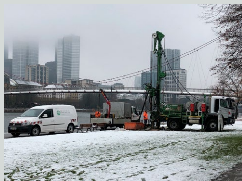
Bohrungen unmittelbar am Frankfurter Mainufer.
