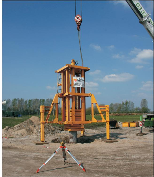
Fallgewicht über einem vorbereiteten Pfahlkopf eines Betonpfahls
